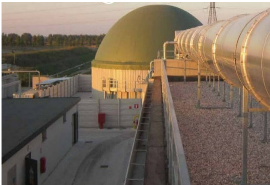
Figura 6: Digestore Anaerobico.
