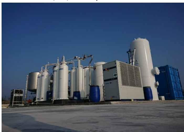
Figura 9: sezione di upgrading.
