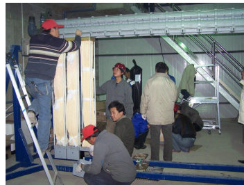
Figura 7: Rimozione dei corpi di aerazione inferiori
