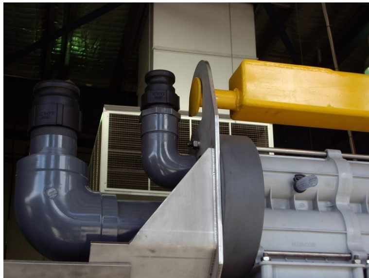
Figura 1: Un Rack MBR scollegato dai collettori e bilancino di sollevamento a posto.
