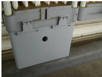
Figura 7: Rimozione dei corpi di aerazione inferiori
