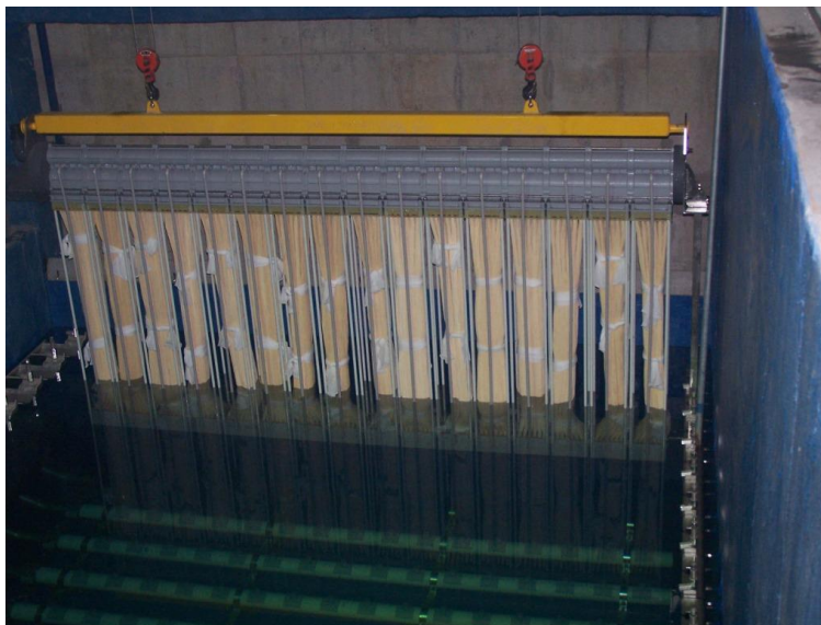
Figura 2: Sollevamento di un insieme di componenti del Rack MBR da una Cella MOS. (Fare riferimento alle ulteriori informazioni sul bilanciamento di sollevamento.)
