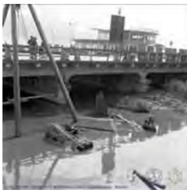
Intervento di tombinatura del torrente Ausa (anni '60) – Muri di sponda e ponte lungomare da demolire
