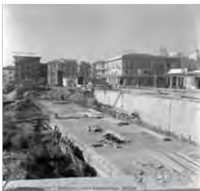
Intervento di tombinatura del torrente Ausa (anni '60) – Muri di sponda e ponte lungomare da demolire
