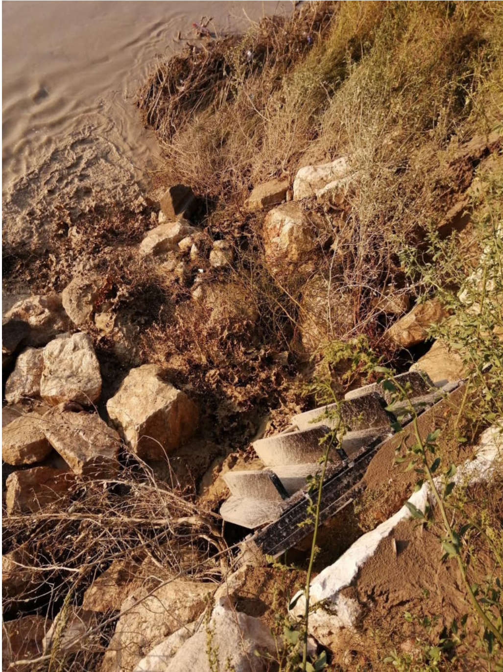
Figura 8.3 – Vista di dettaglio dall’alto dello scarico n. 27
