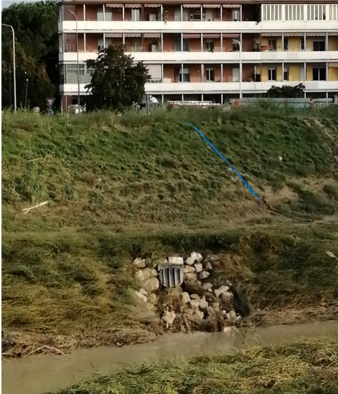
Figura 8.2 – Vista frontale dello scarico n. 27
