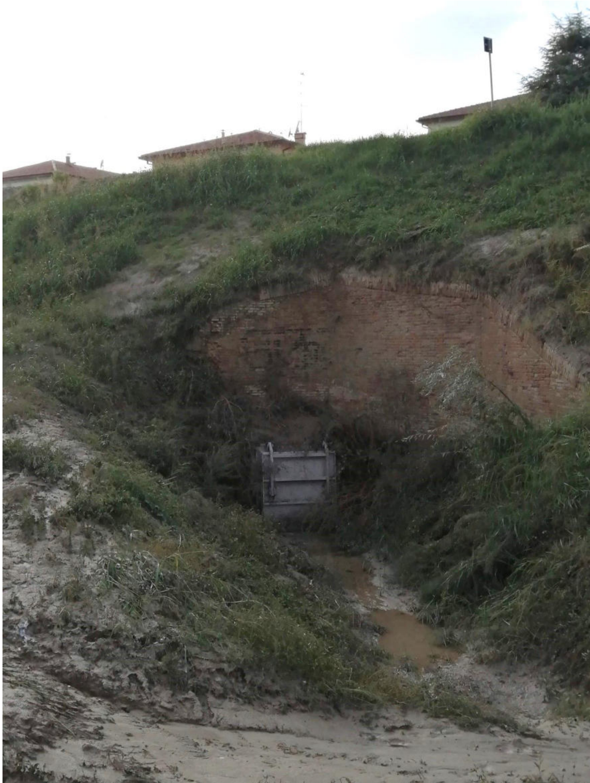
Figura 8.2 – Vista frontale dello scarico n. 37
