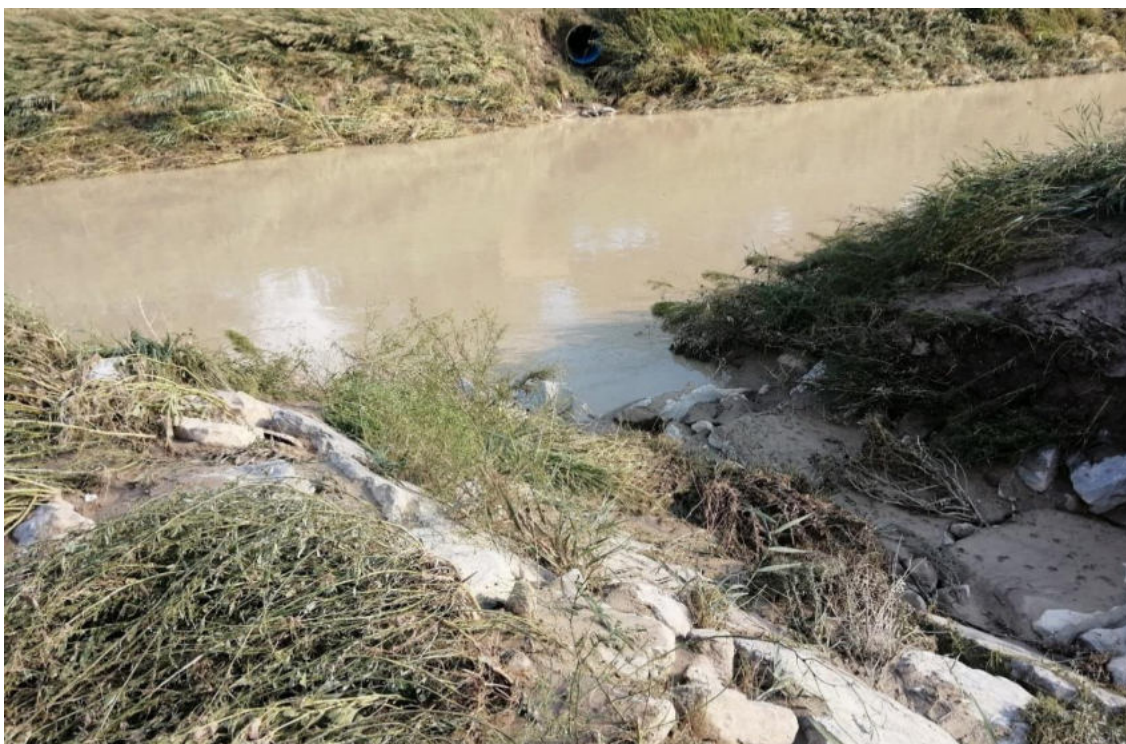
Figura 8.3 – Vista della canalizzazione verso fiume dello scarico n. 33
