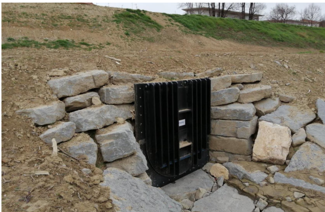
Figura 8.2 – Vista frontale dello scarico n. 33
