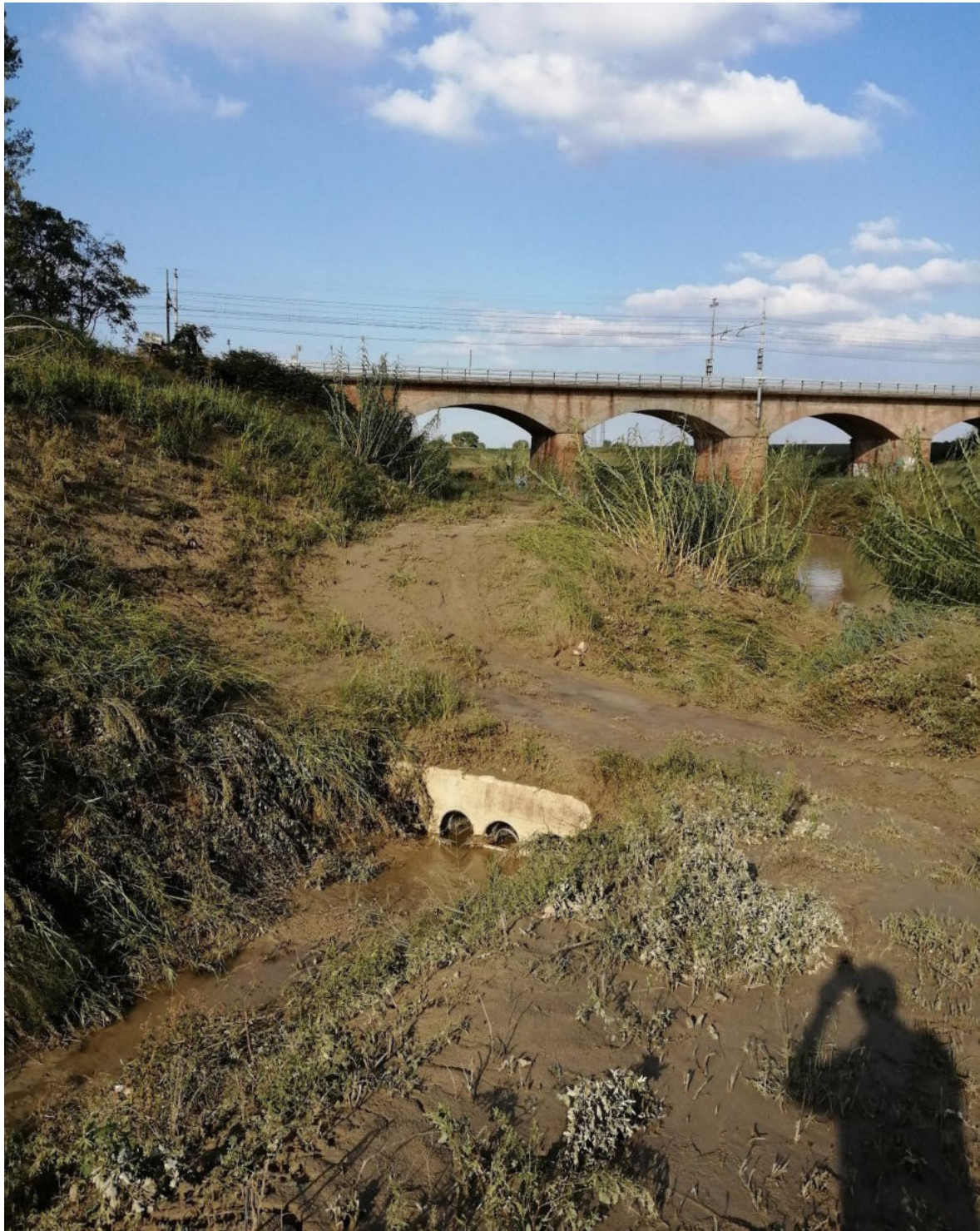
Figura 8.3 – Vista da monte verso valle dello scarico n. 37
